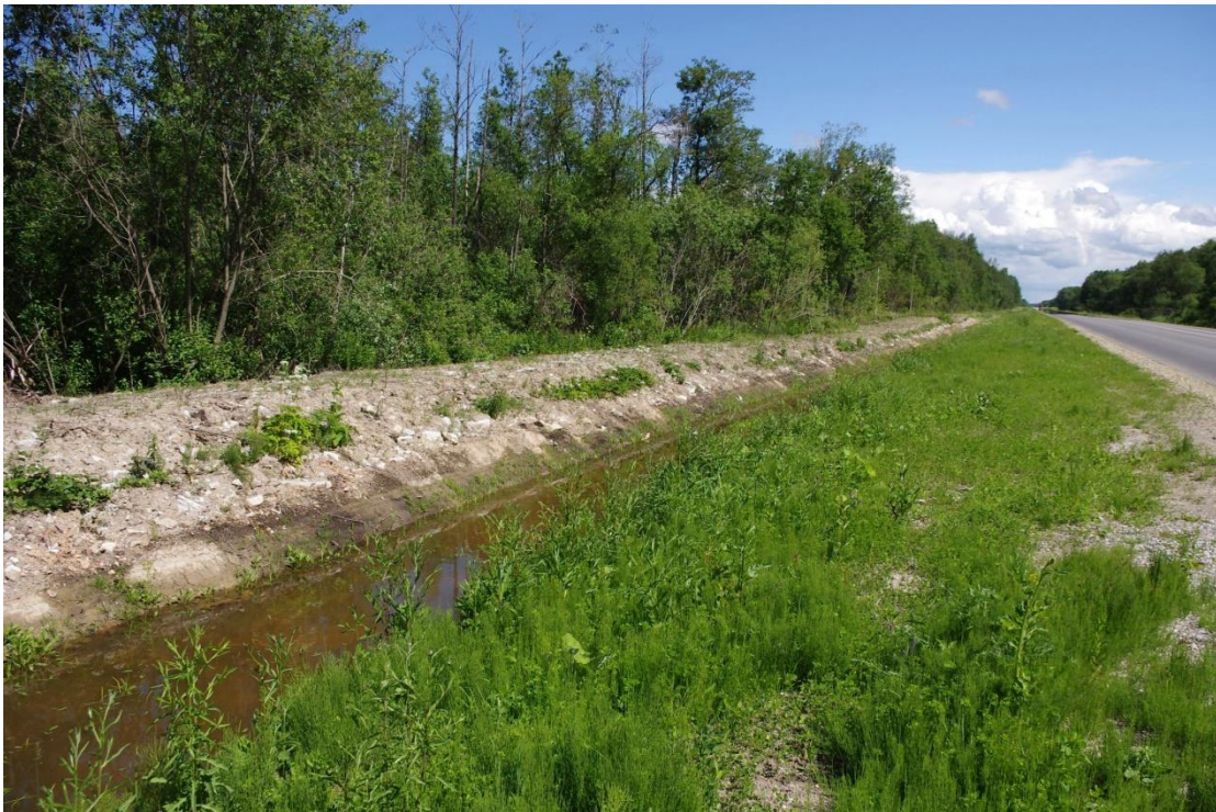
Figure 7. View on the test section after completing the works / Vaade katselõigule pärast tööd lõppu (29.06.2012, R. Pajula)
