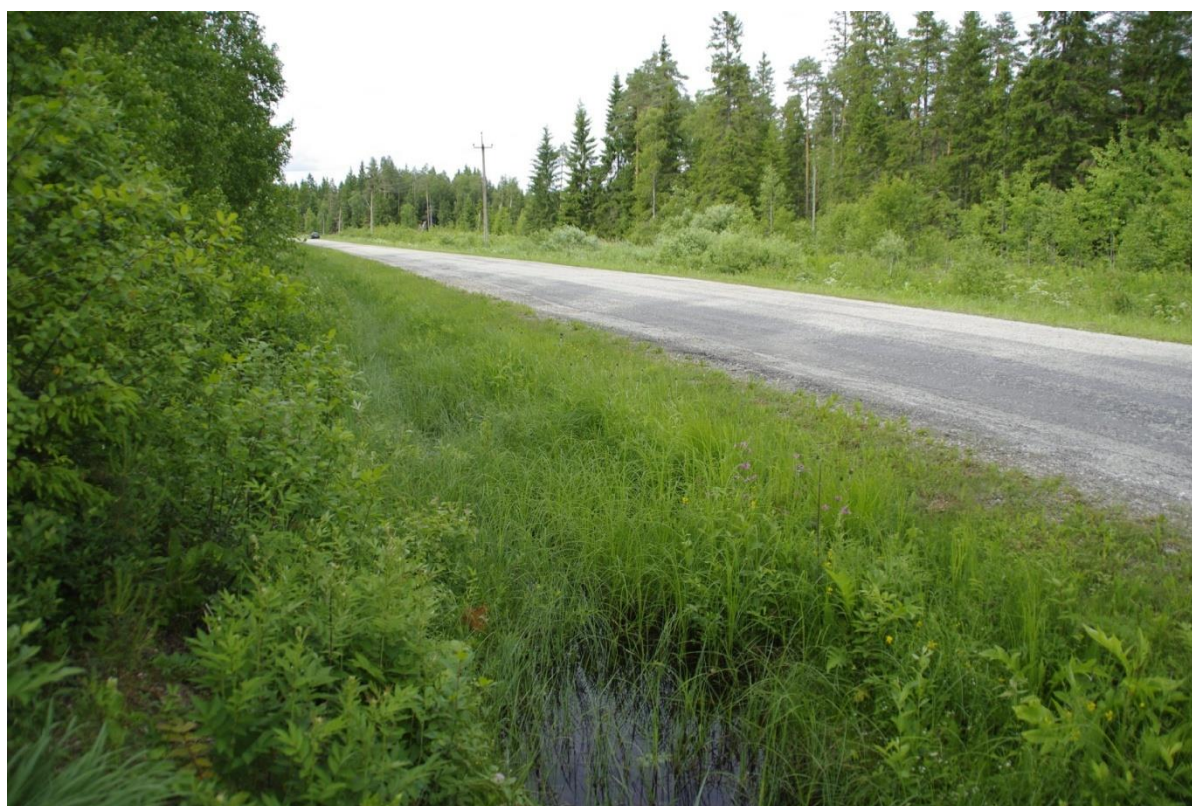
Figure 3. The western ditch of the Simuna-Vaiatu road section (20.06.2011) / Simuna-Vaiatu teelõigu läänepoolne kraav 20.06.2011
