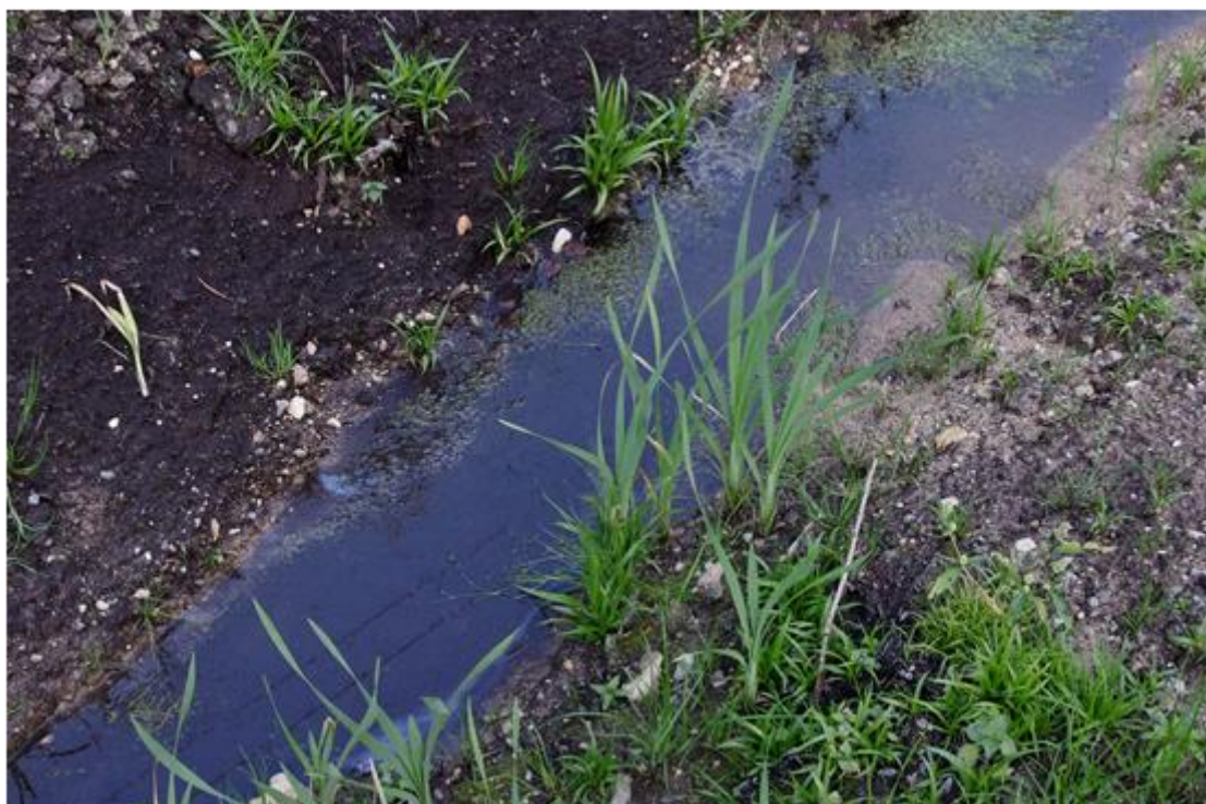
Figure 18. Emerging moisture-loving vegetation in the bottom of the roadside ditch in 2014 (2014, R. Pajula) / Kujunemisjärgus niiskuslembene taimkate külkraavi põhjas, kattelõigu keskosas 2014. aastal (2014, R. Pajula)
