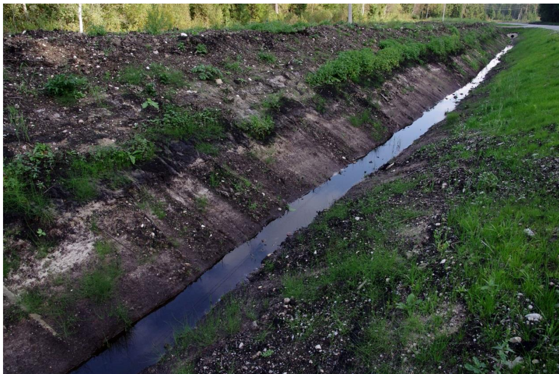
Figure 17. The left (eastern side) road edge of the southern side of the test section in 2014, view looking to the south. Soil from road dredging works has been deposited onto the outside area behind the ditch (2014, R. Pajula) / Katselõigu lõunaosa vasak (idapoolne) teeserv 2014. aastal, vaade lõuna suunas. Kraavi taha on ladestatud ja tasandatud tööde käigus üle jäänud pinnast (2014, R. Pajula)
