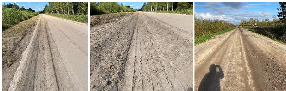
Joonis 7.14. Fotod RMK metsatee seisukorrast tuha laotamise käigus (sisse tekkisid ulatuslikud püsivad deformatsioonid) ning peale metsamaterjali väljavedu (liivased sektsioonid toimisid hästi, metsakõduga piirkonnad lagunesid).
