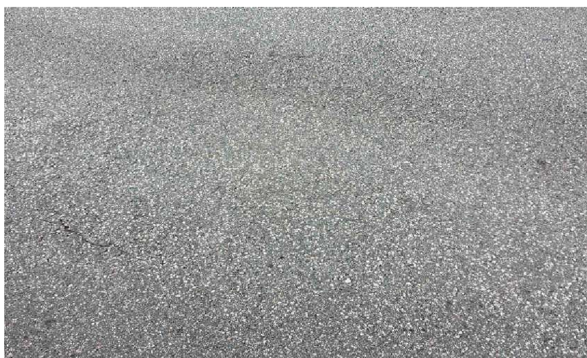
Foto 7.4. Narva-Mustajõe objekti katselõigus B võrkprao alged. Need võivad olla tingitud asfaltbetoonist, aga ka stabiliseeritud kihist. See tuleb välja selgitada järgneva uuringu raames.
