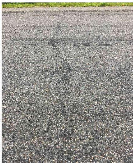
Foto 7.12. Põikpragu tuhkstabiliseeritud sektsioonis (mass-stabiliseerimise peal).
