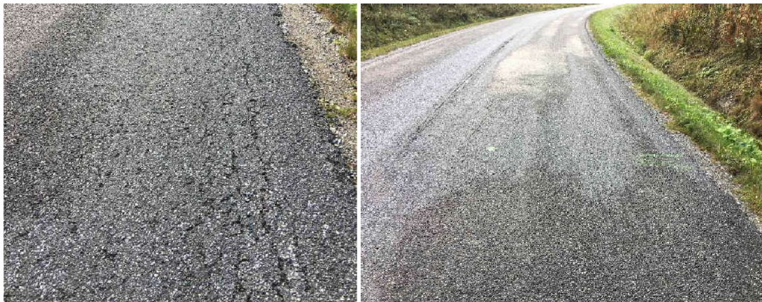
Foto 7.11. Võrkpragu lõigu 4 alguses, tee keskel on näha ka pikipragu.
