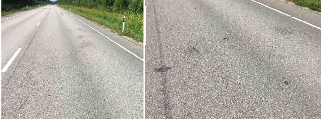
Foto 7.7. Narva-Mustajõe objekti katselõik D oli kõige halvemas seisukorras. Teekattel oli mitmeid defekte, mis viitavad sellele, et stabiliseeritud segu on niiskustundlik.
